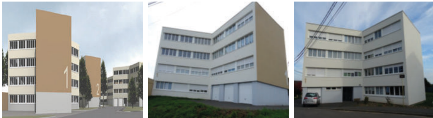
RÉHABILITATION DE 4 IMMEUBLES, 50 LOGEMENTS - Impasse des Genêts (Chapelle - HHT)
