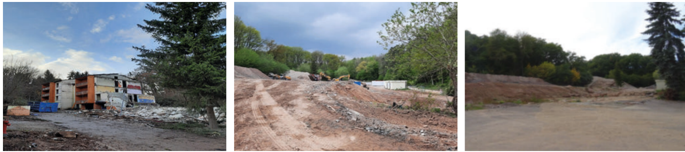
DÉMOLITION DE 83 LOGEMENTS - Rue du Ruisseau (Chênes - HHT)
