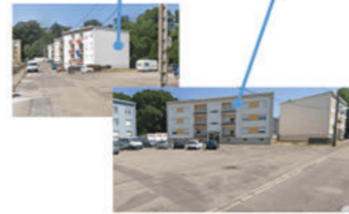
DÉMOLITIONS - Chapelle HHT
