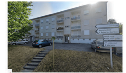
DÉMOLITIONS - Chênes HHT
